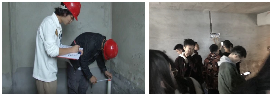
图 7-8 学生工地学习实景照片
