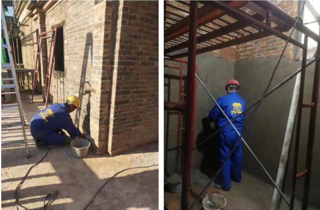
图 79-80 工艺岗位优秀学徒生李子豪、邓超进入工地现场施工
