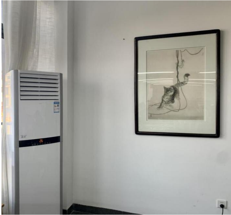
图 13 新增 1 台空调、1 幅湘绣
